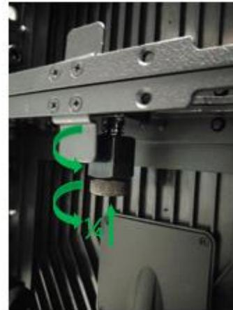
14. Engagez les vis, les rondelles et les écrous dans les emplacements (fourni avec le cabinet)
